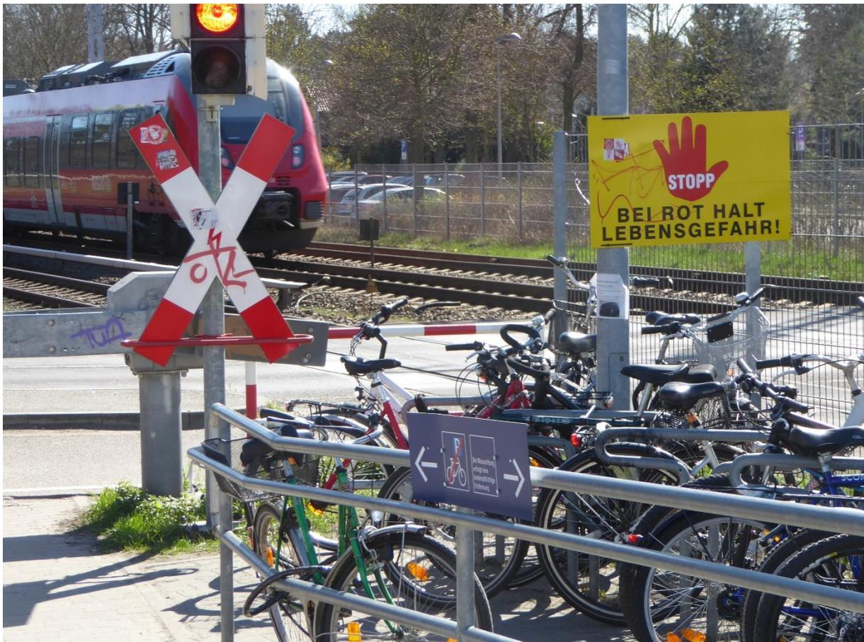
Bahnübergang S-Bahnhof Zeuthen: Bahnsteigzugang zur S-Bahn mitten im Bahnübergang über eine viergleisige Strecke mit dichtem Verkehr. Foto: Innoverse
